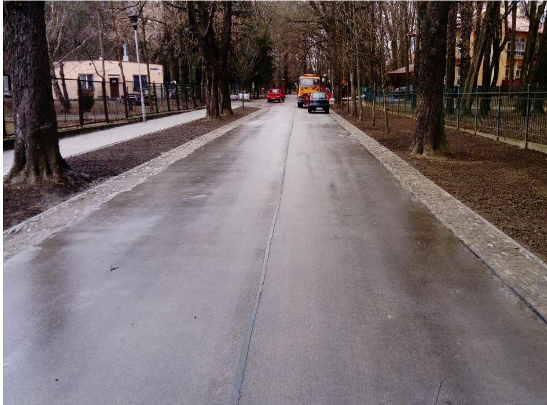
Przebudowa ul. Szczepańskiego
