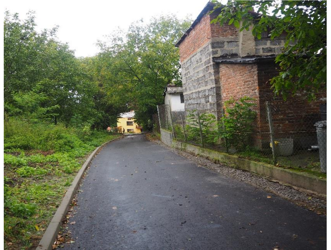
Przebudowa ul. Kruhel Pełkiński od nr 45–53A
