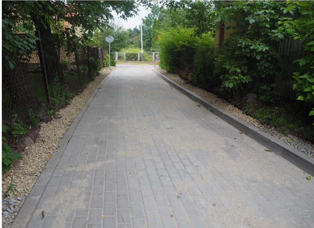
Przebudowa ul. Asnyka
