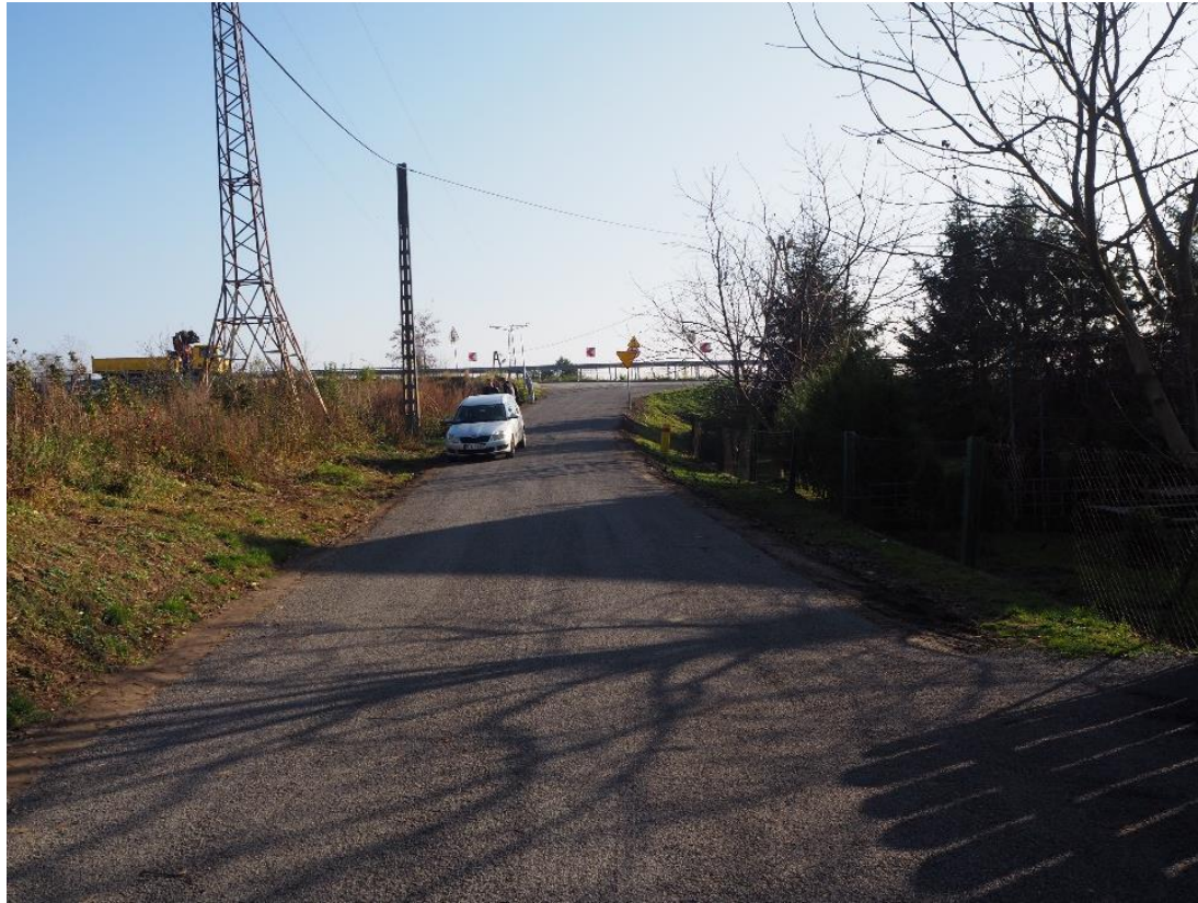
Przebudowa ul. Bocznej Szczytniańskiej
