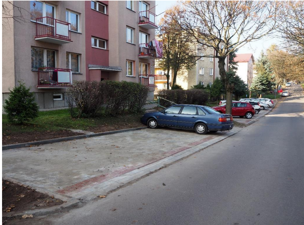
Budowa parkingu przy ul. Legionów – bloki 20, 22, 24
