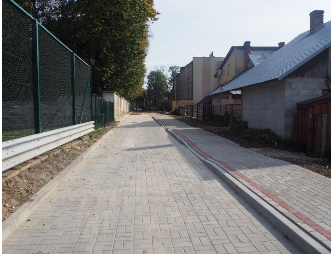
Przebudowa ul. Przyklasztornej
