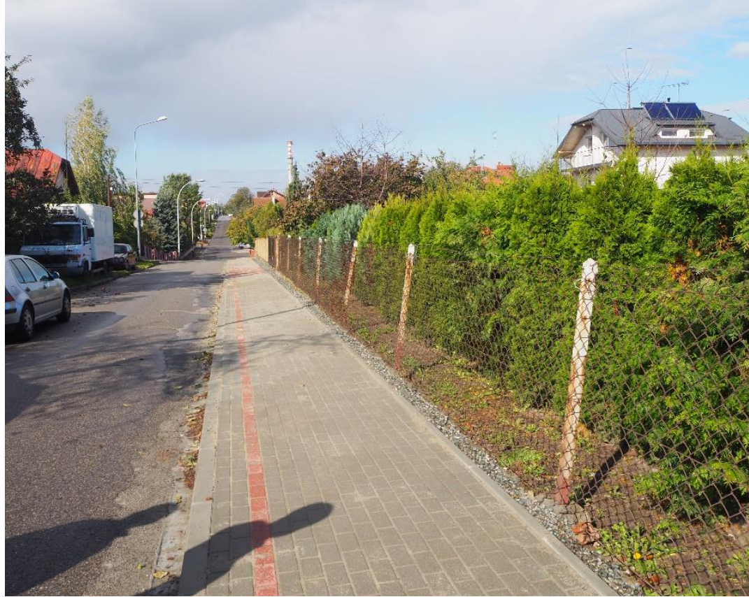
Przebudowa chodników przy ul. Chrobrego
