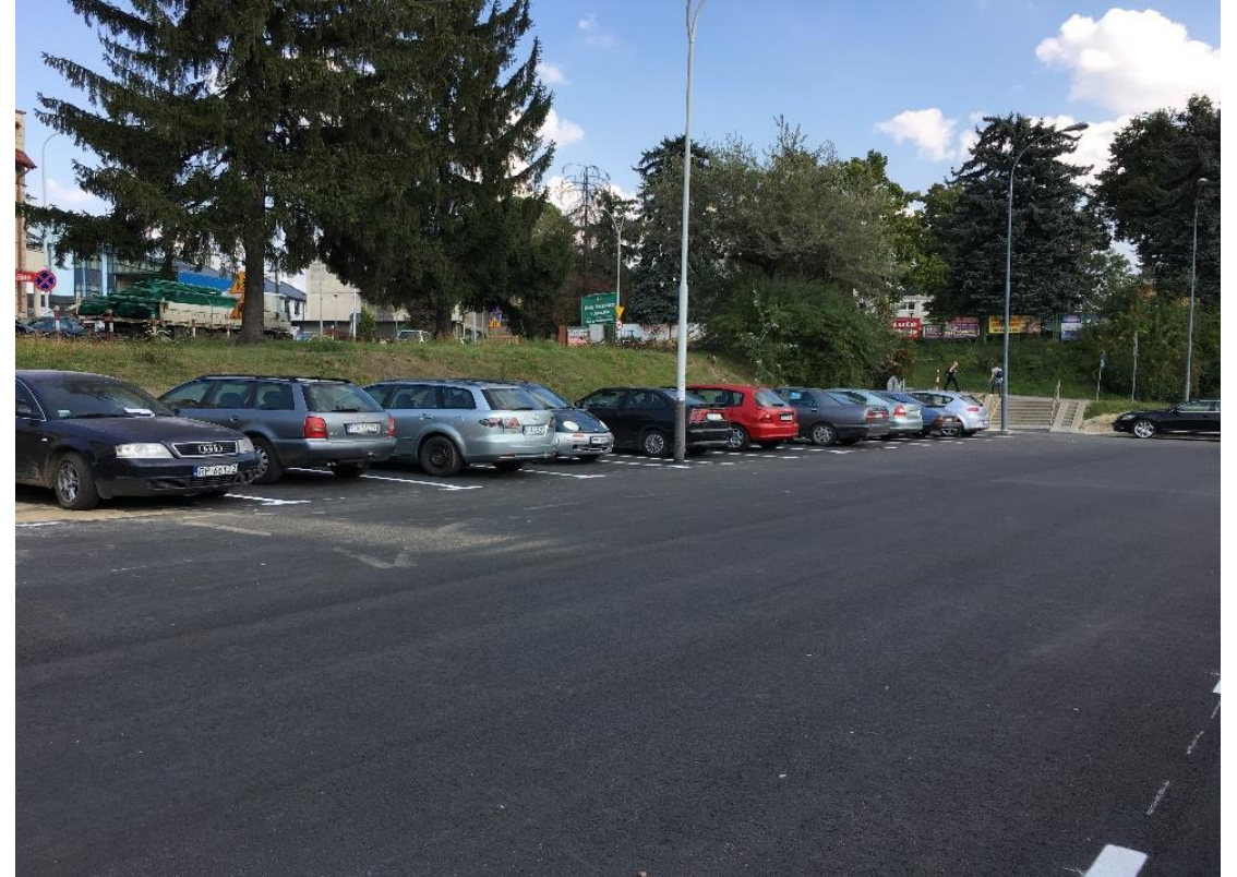
Budowa parkingu przy dworcu PKP
