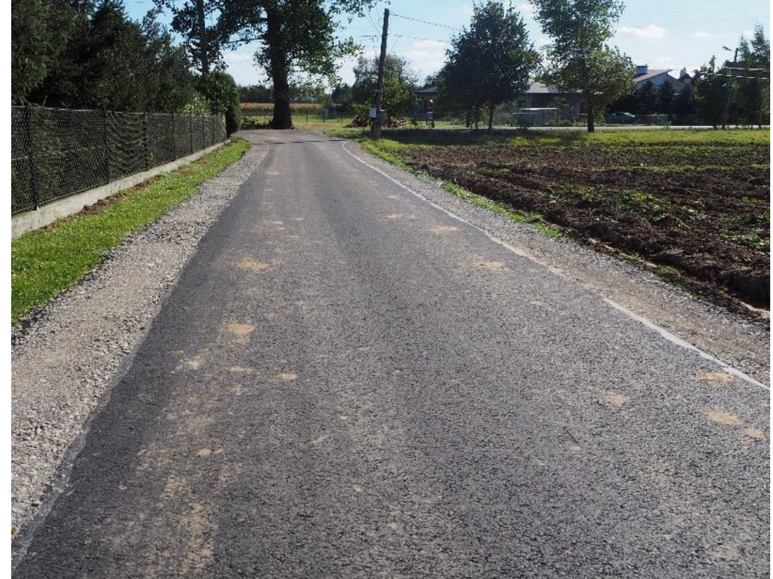
Przebudowa ul. Piaskowej
