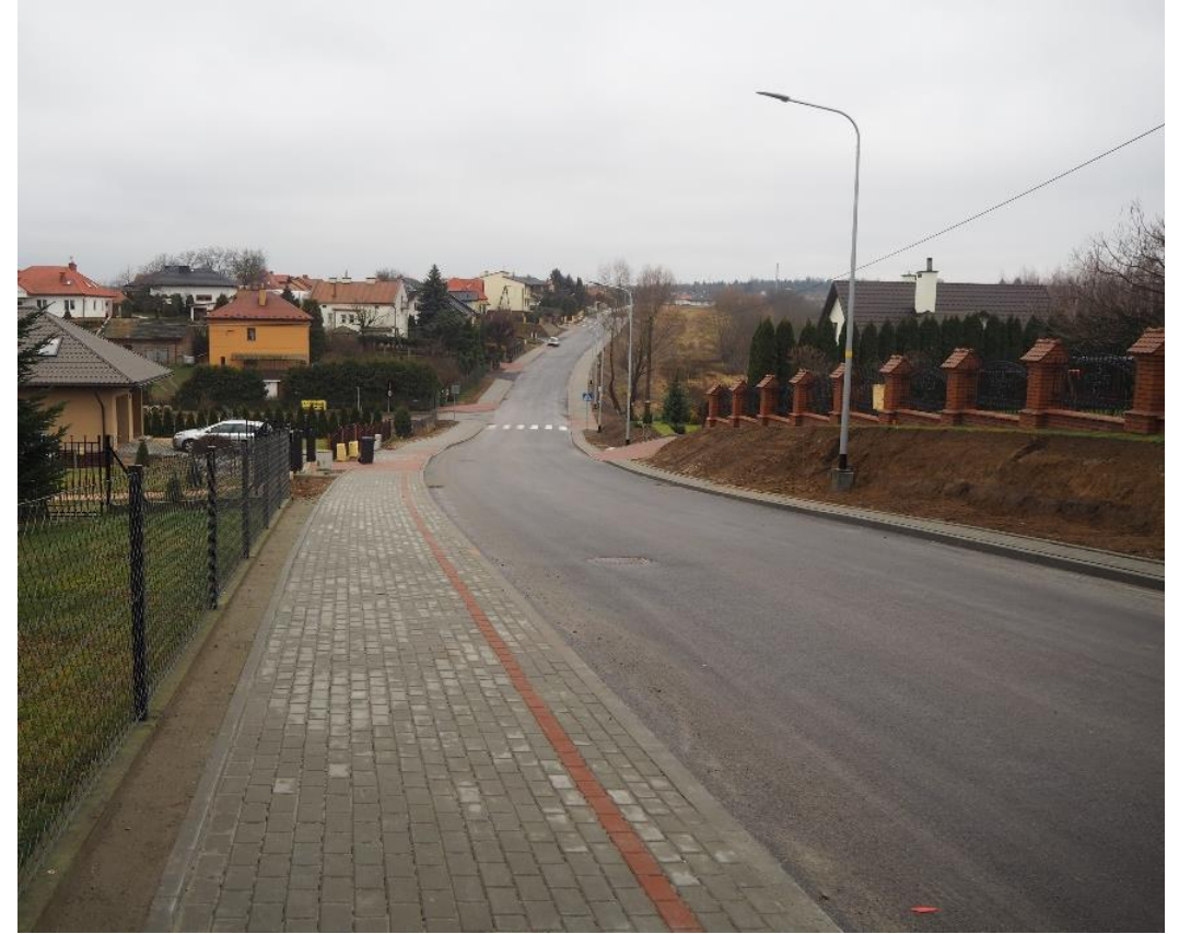
Rozbudowa ul. Łączności
