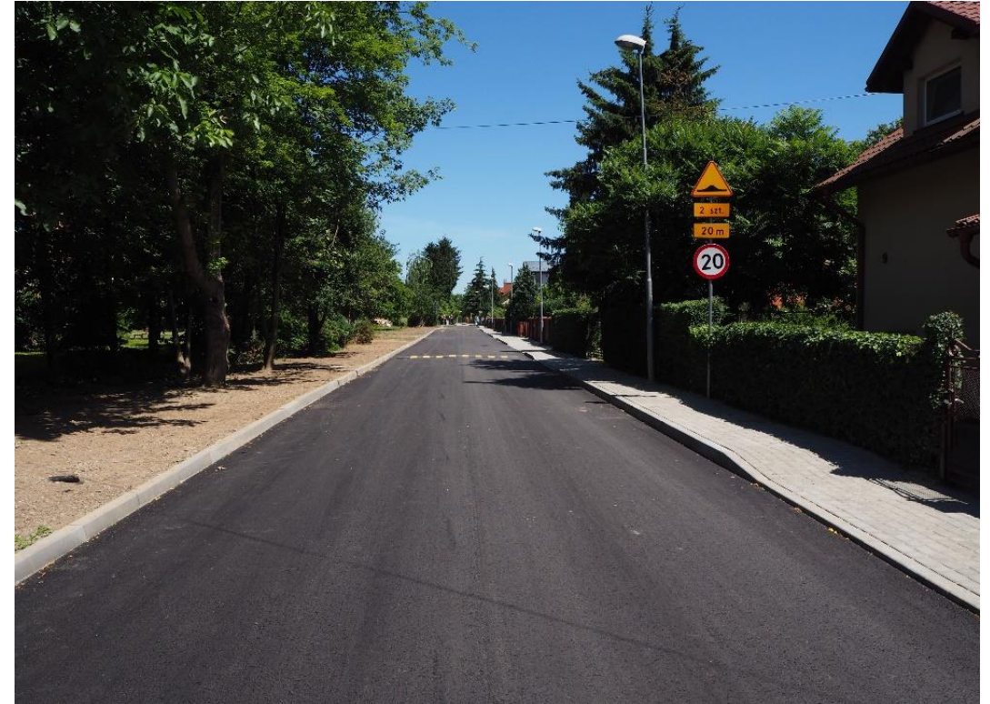
Przebudowa ul. Raszyńskiej
