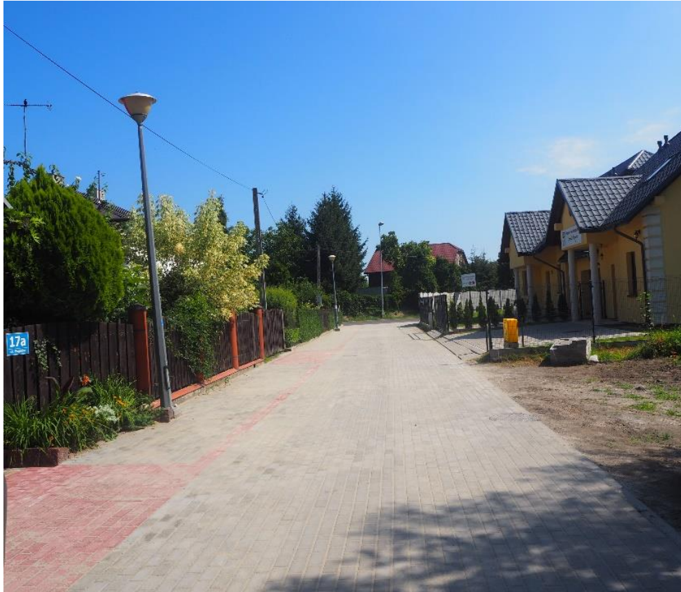
Przebudowa ul. Bocznej Pogodnej
