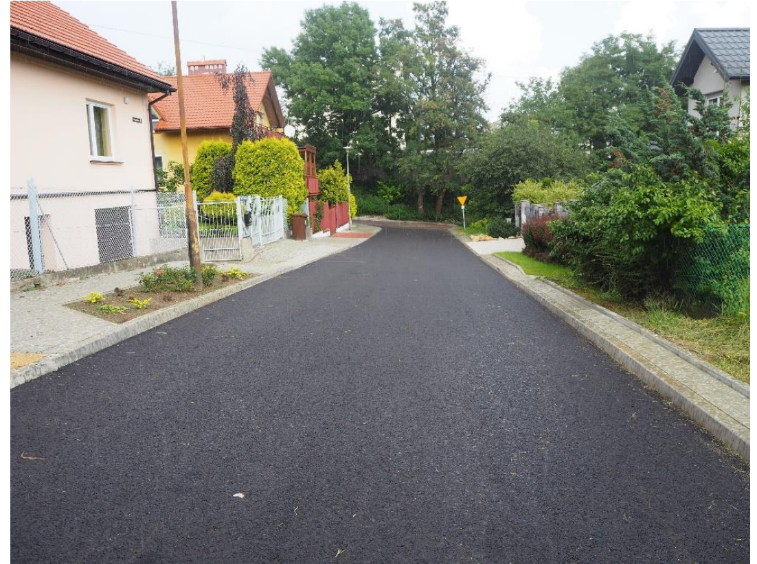
Przebudowa drogi i chodnika ul. J. Skrzyneckiego (II etap)
