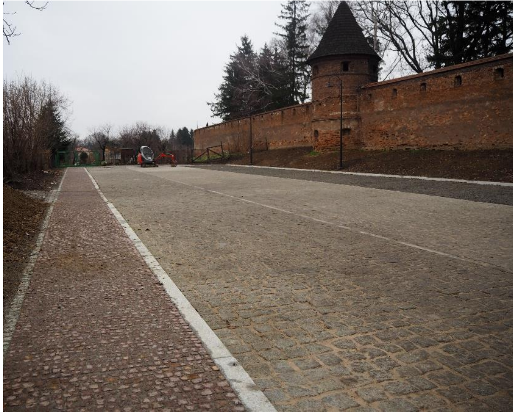
Budowa parkingu przy ul. Benedyktyńskiej
