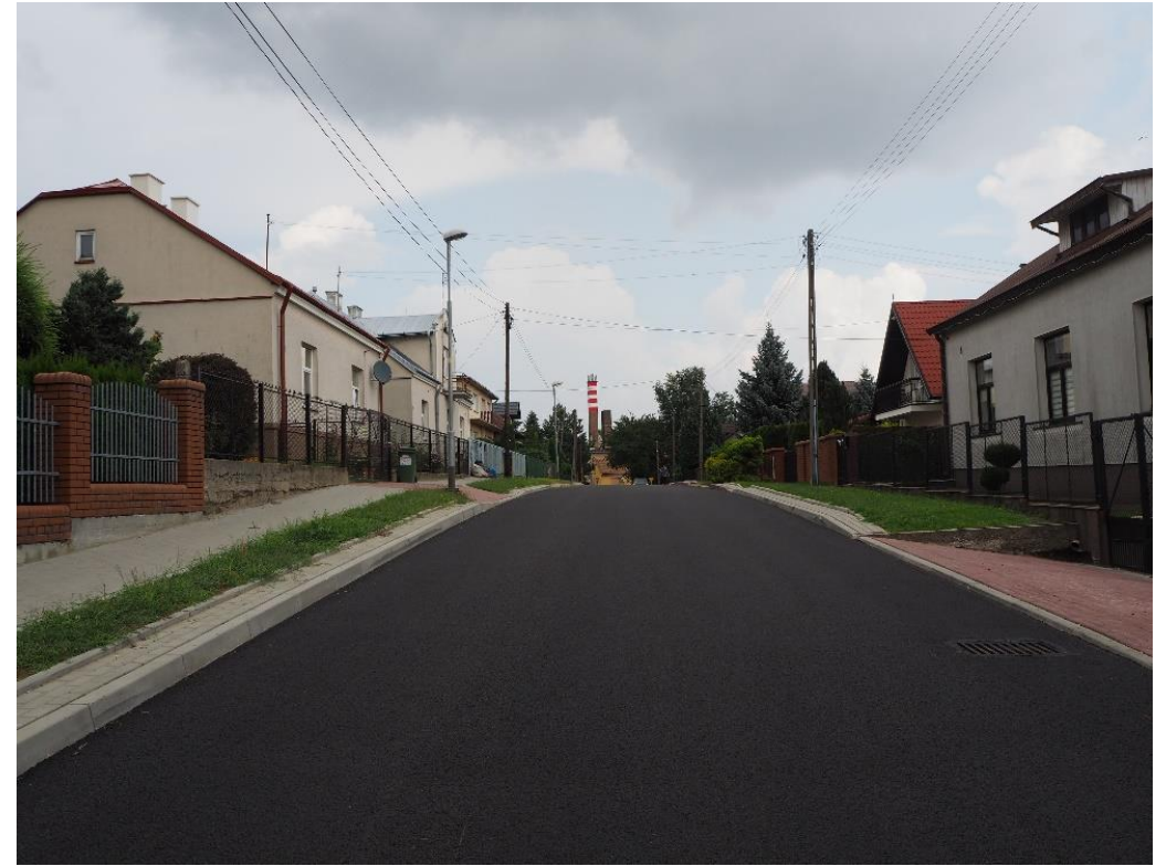
Przebudowa ul. Chłopickiego (II etap)
