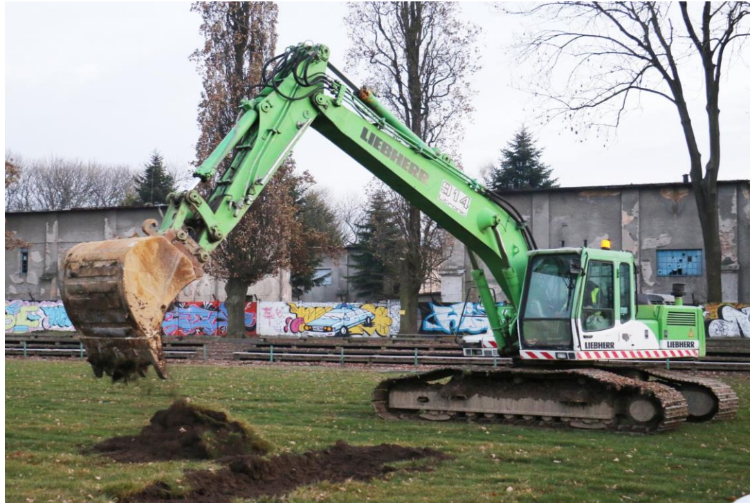
Budowa stadionu miejskiego – „szkolnego” przy ul. Piekarskiej
