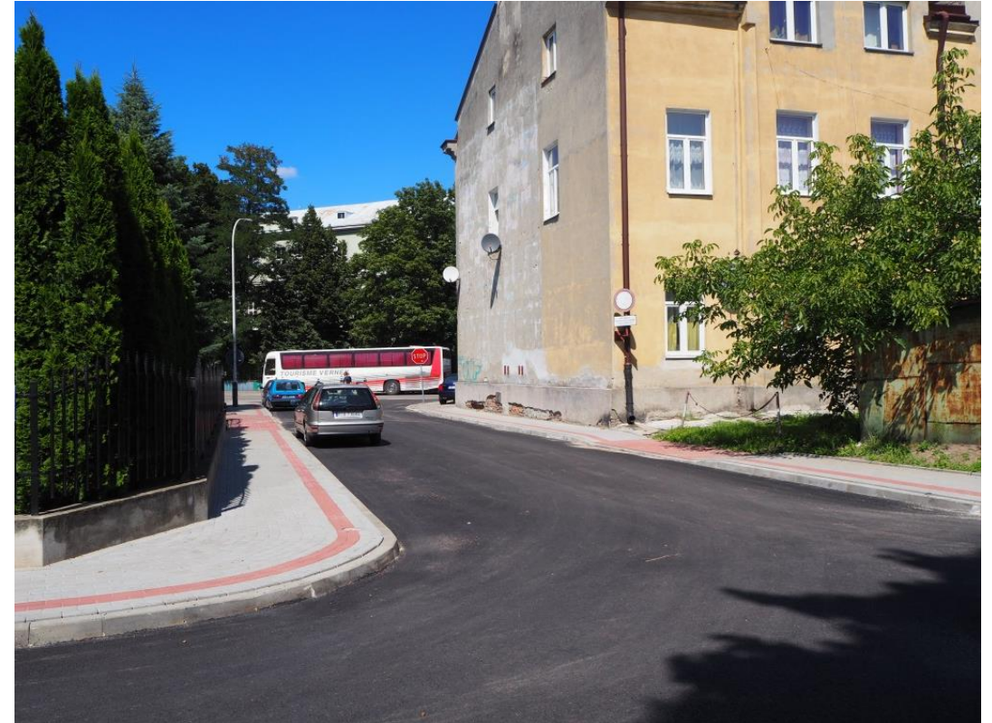
Przebudowa ul. Konarskiego
