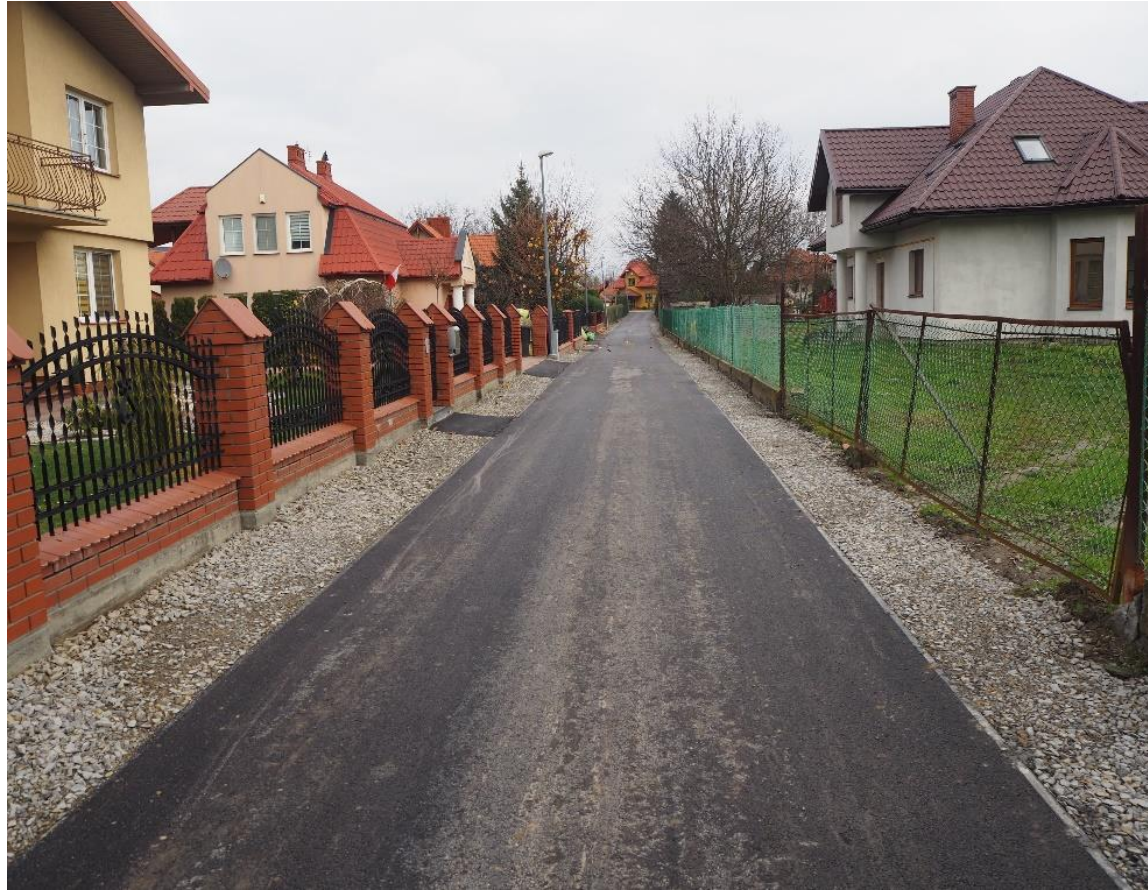
Przebudowa ul. Rajskiej (I etap)
