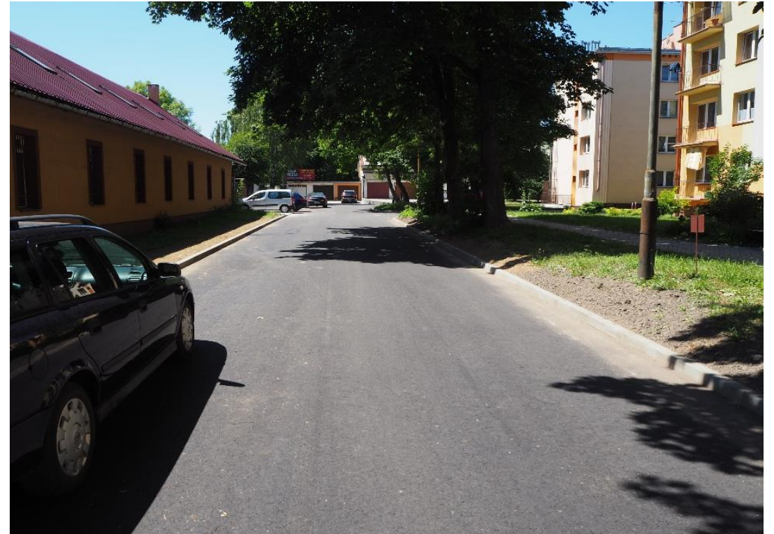
Przebudowa ul. Nartowskiej (III etap)
