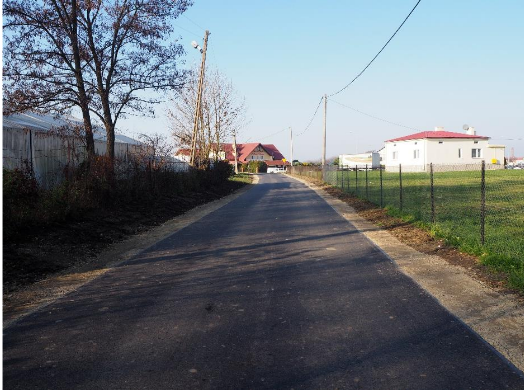
Przebudowa ul. Bocznej Sanowej
