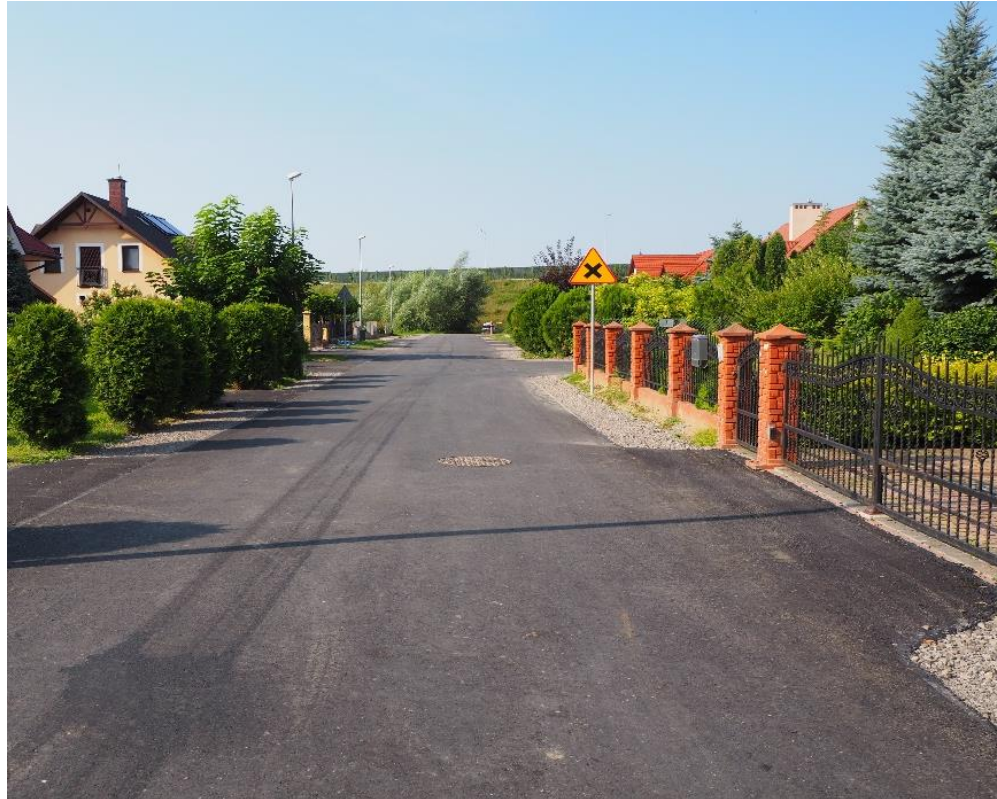
Przebudowa ul. Wiśniowej
