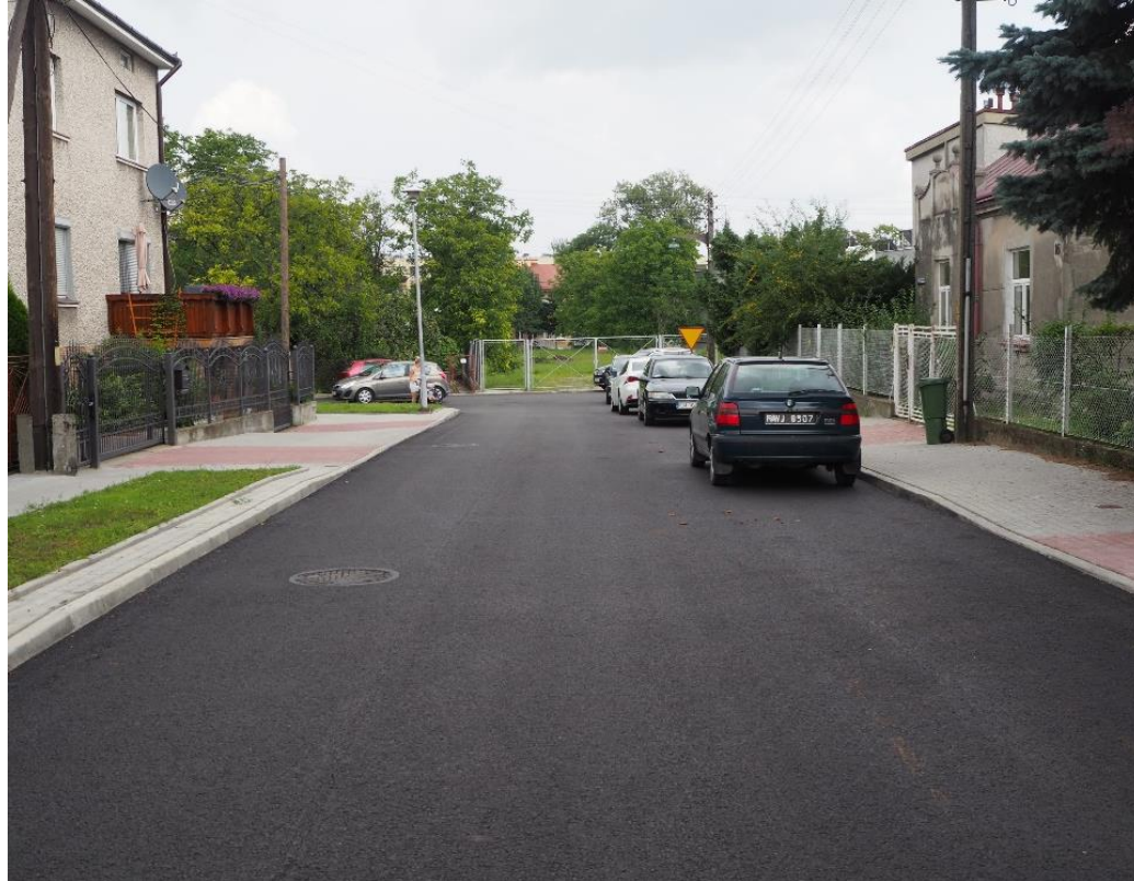
Przebudowa drogi i chodnika ul. 29 Listopada (II etap)
