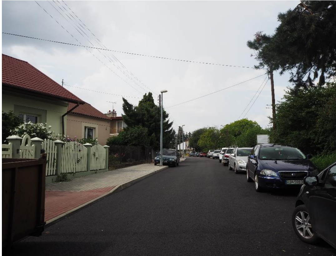
Przebudowa ul. Nabelaka (II etap)
