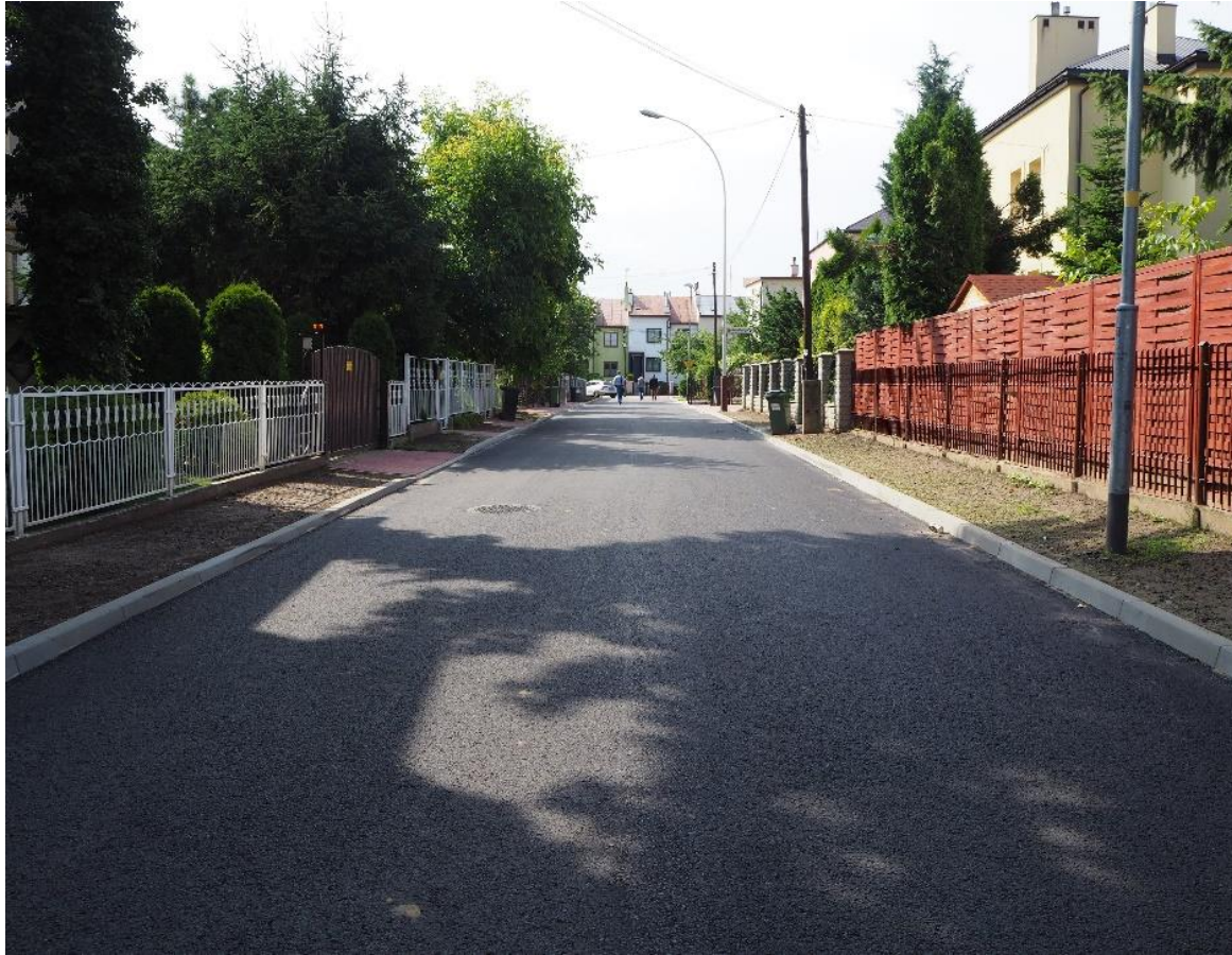
Przebudowa ul. Kossaka
