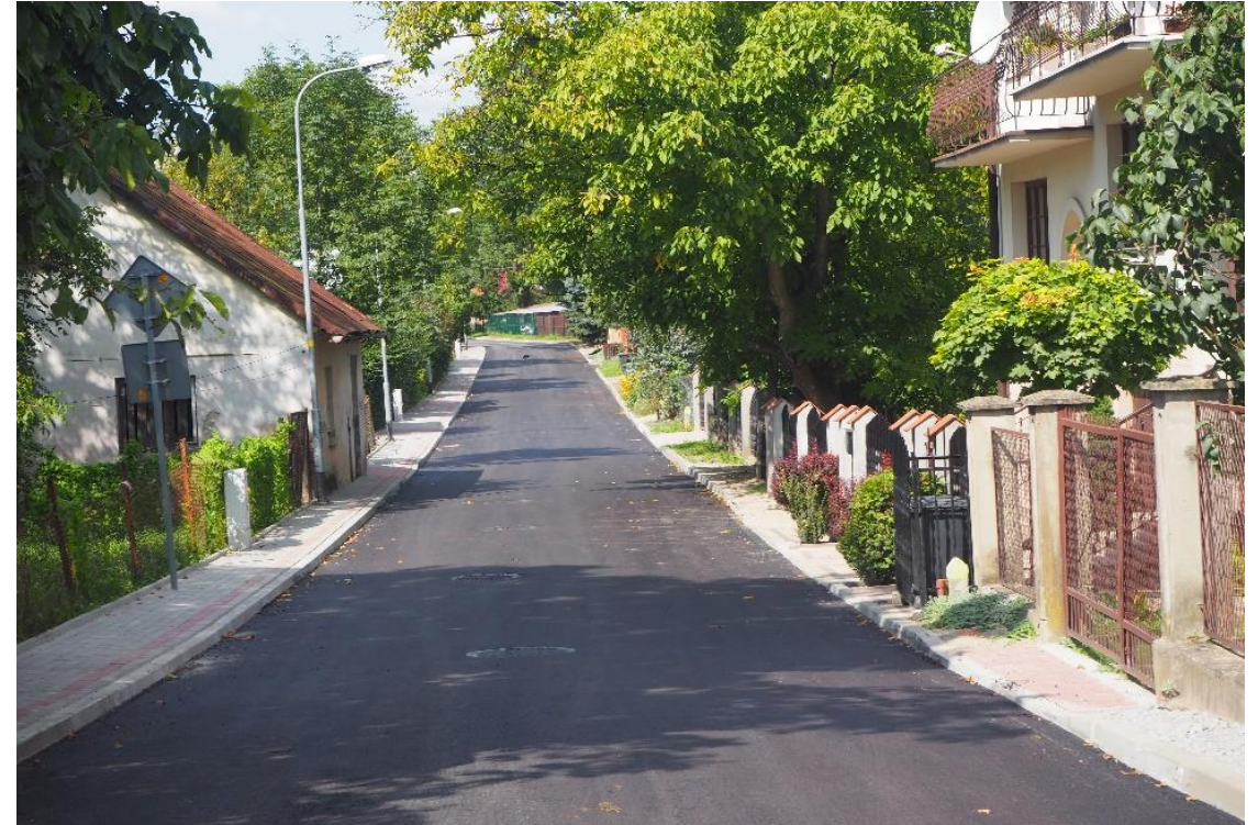
Przebudowa ul. Blichowej
