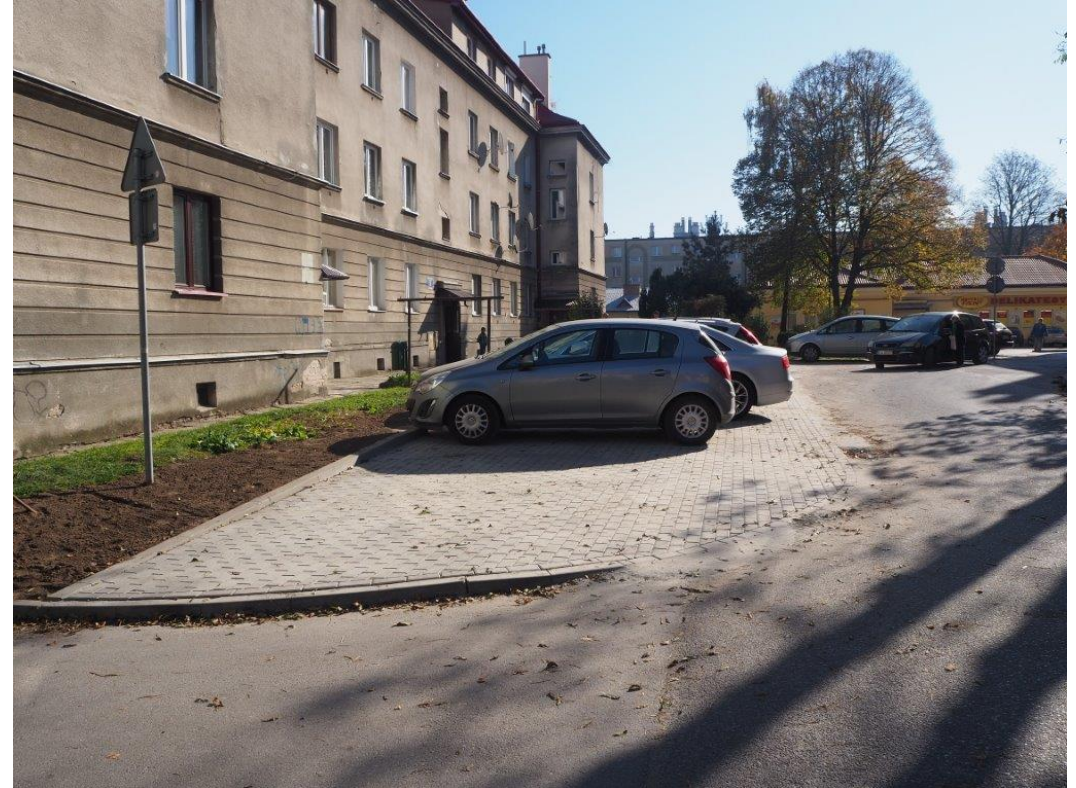
Budowa parkingów na os. 1000 - lecia (II etap)
