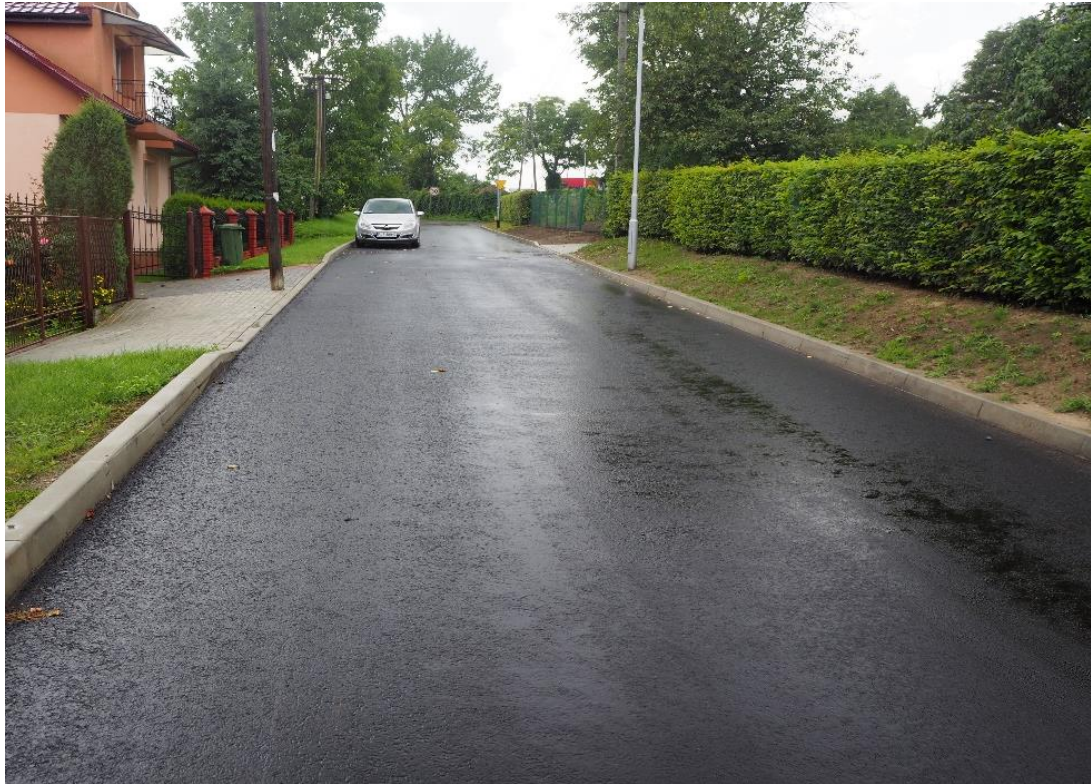
Przebudowa ul. Czechowskiego (II etap)
