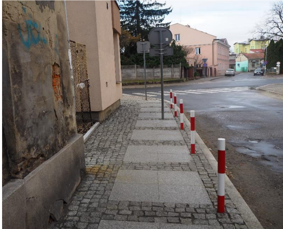
Przebudowa chodnika przy pl. Mickiewicza
