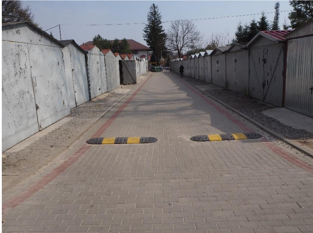
Przebudowa placu przy ul. ks. J. Makary
