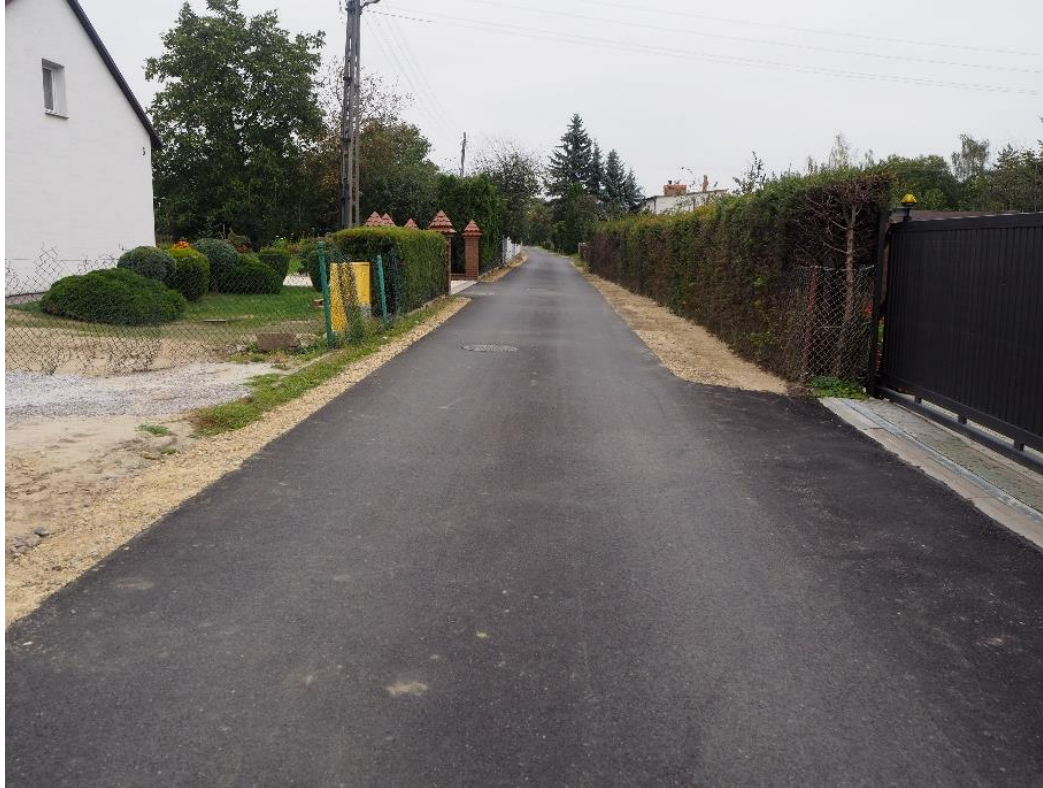
Przebudowa ul. Dziewiarskiej
