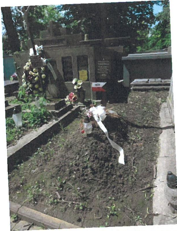
Nagrobek Stanisława Sierpińskiego przed rozpoczęciem prac.
